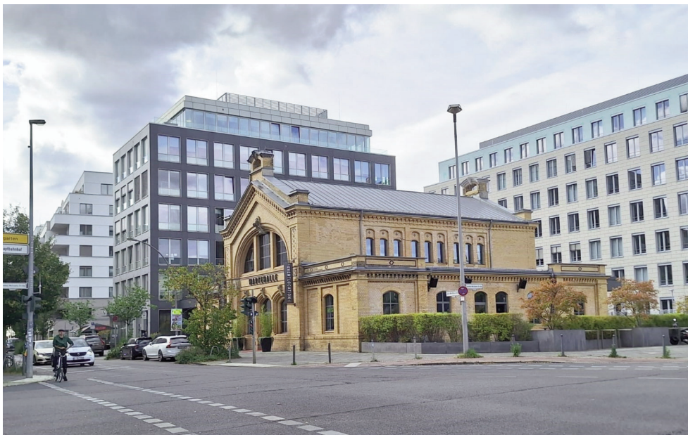
Abbildung 1: Wartehalle Berlin: die restaurierte Wartehalle des ehemaligen Stettiner Bahnhofs in Berlin
